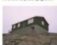
Figur 3. Bygning med støbt krybekælderfundering på støbt underlag.
