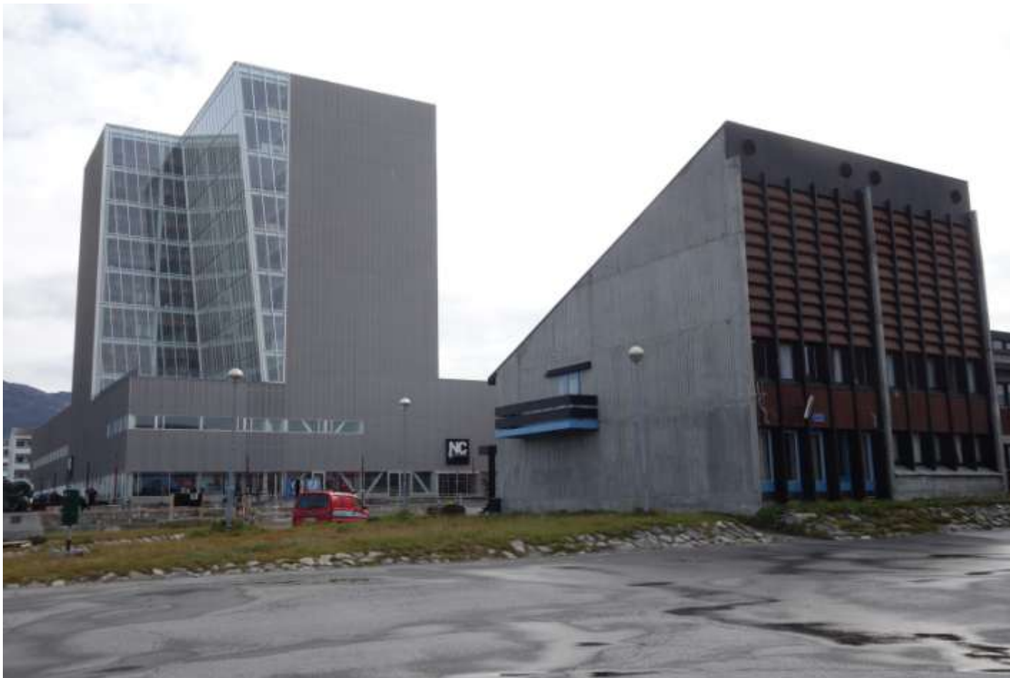
Inatsisartut-bygning og Selvstyrets administrationsbygning, Foto Kristian Lennert 2014
